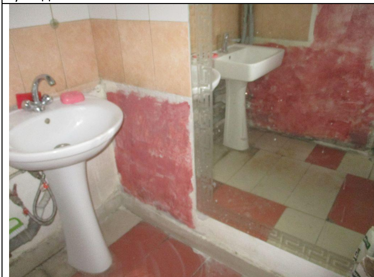
Кор.3, эт.-1 Техническое помещение Устройство фартука из керамогранита -подготовка поверхности -укладка плитки
